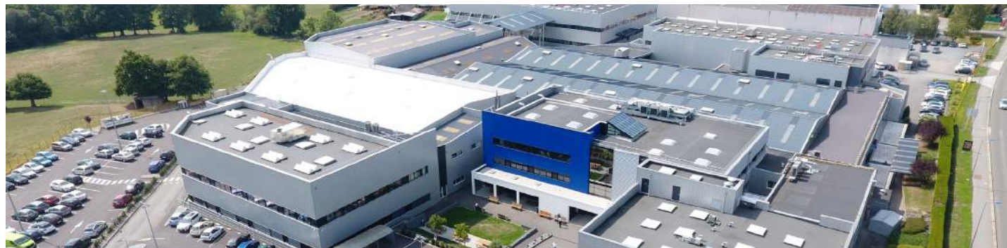
Stabilimento di Saint-Berthevin-Francia
