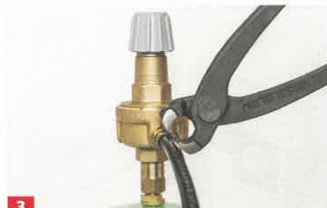
3 ... der mitgelieferten Schlauchschellen aufschieben. Schelle über die Tülle schieben und mit einer Beißzange verquetschen.
