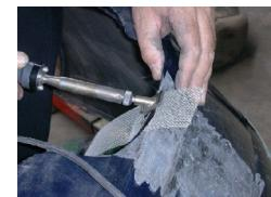
Üben Sie keinen zu starken Druck auf den Lötkolben aus. Die 550°C der Lötkolbenspitze genügen vollkommen, um den Kunststoff durch das Gitter aufzschmelzen zu lassen. Bereits nach dieser kostengünstigen Reparurmaßnahme besitzt Ihre Stoßstange ausreichend Festigkeit gegenüber Belastung und Stößen (Foto 2).
